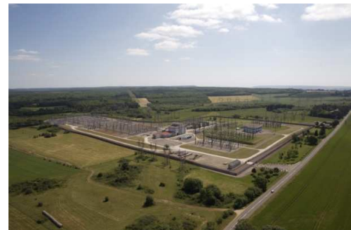
Un poste électrique à 400 000 Volts
